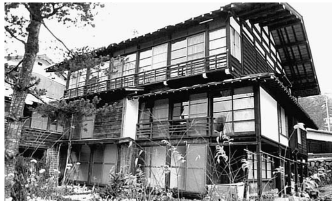
昭和59年の城山館：背面側二階から一階にかけて半間の下屋が妻側まで廻って廊下となっていた。
