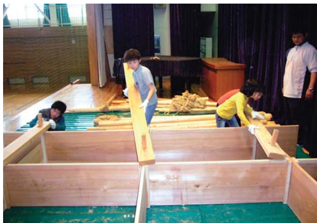
2. 土台の上にウス梁を載せます。ようやく組立作業らしくなってみんなやる気満々です。
