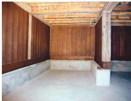
修理後倉庫：防水シート上に土間コンを打設し湿気の問題を解消した。
