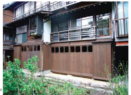
修理後背面外観：当初雨戸が残っていたので、雨戸の外観を復原。
