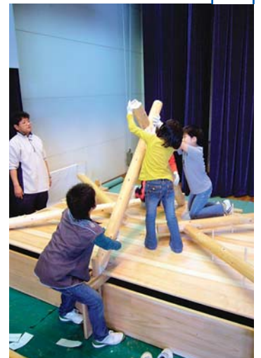
3. ウス梁の上に合掌を組みます。倒れない用に一生懸命支えます。
