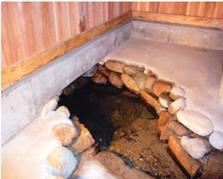
修理後のシュウズ場：土台をシュウズの湿気を受けないレベルまで上げてコンクリート梁を渡した。正面側各部屋の土台レベルはこの高さを基準とした。
