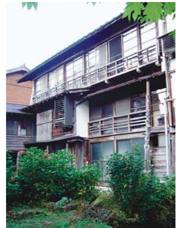
修理前背面外観：アルミサッシが入っている。
