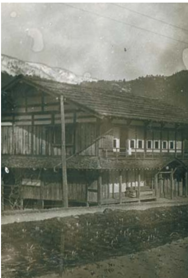
大正末～昭和初期の城山館：正面庇に破風のついた外観だった。二階の軒に持ち送り付き腕木が見える。
